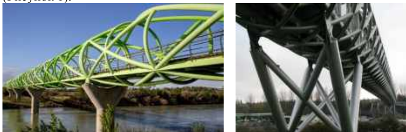
Рисунок 1 – «Двухсотлетний» пешеходный мост в Испании и пешеходный мост «M8 Harthill» в Великобритании
