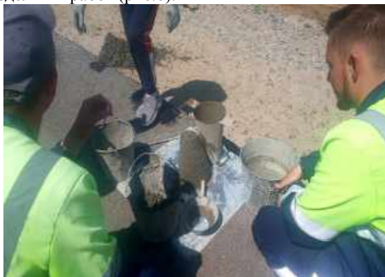
Рисунок 6 - Проверка подвижности бетонной смеси водоотводных лотков
