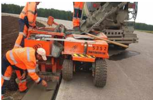
Рисунок 7 - Кладка монолитных бетонных лотков на развязке трассы Р 254
